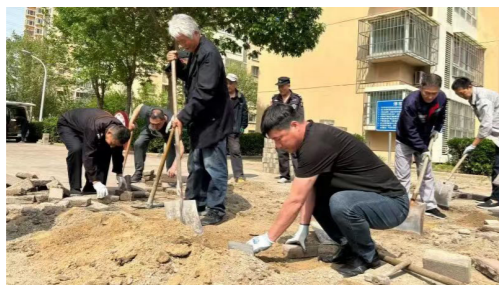
物业工程队为居民铺路
